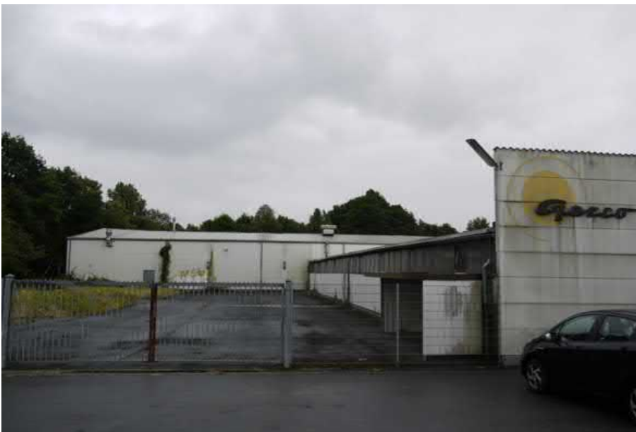
Abb. 2: Blick auf die aufgegebene Apparatefabrik (Juli 2019)
